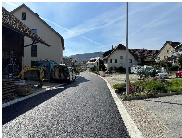
Deckbelag eingebaut
