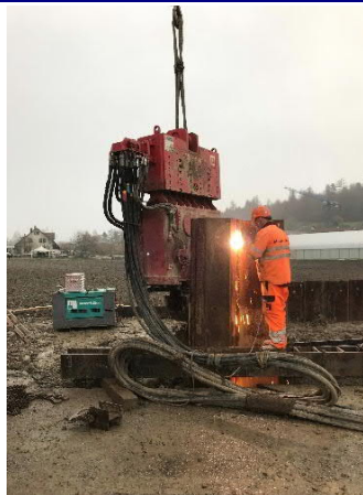
Spundwand-Schweissarbeiten
