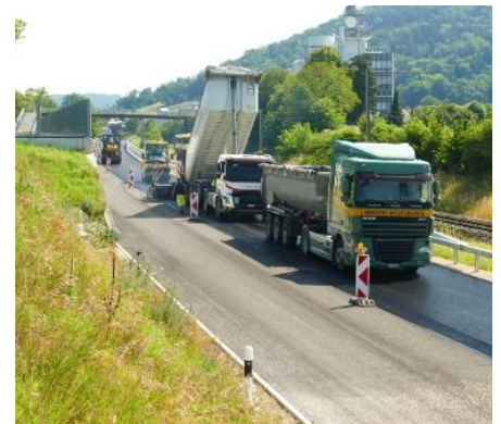
Einbau Deckbeläge
