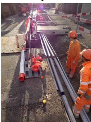
Rohrlegung EW-Trasse
