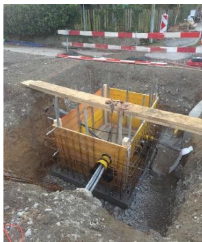
Kabelzugschacht EW
