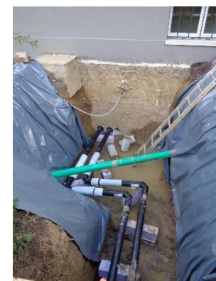
Hausanschluss Fernwärme
