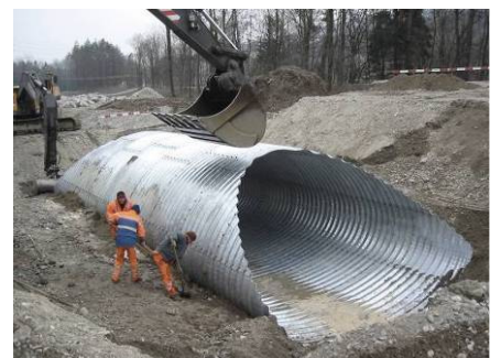
Versetzen des Wellstahlprofils
