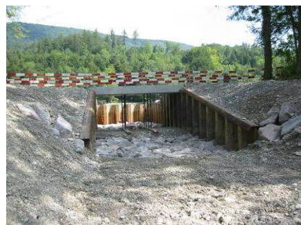
Unterwasseransicht des Rohbaus
