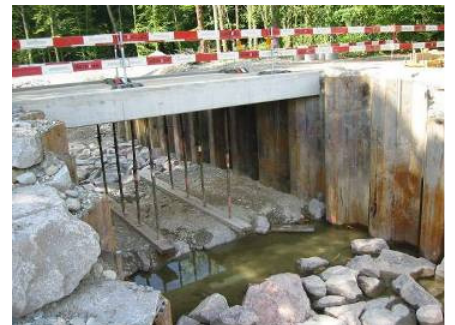
Betonierte Brückenplatte
