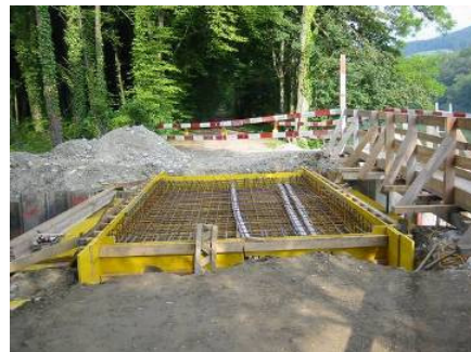
Armierung der Brückenplatte
