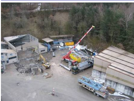
Rückbau der bestehenden Anlage
