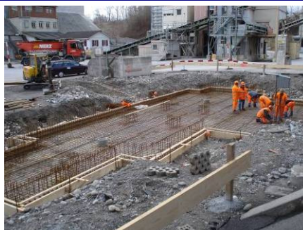
Bewehrung der Fundamentplatte
