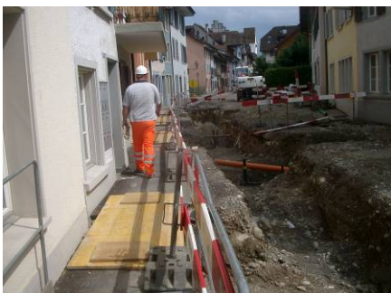
Bruggerstrasse während Bau
