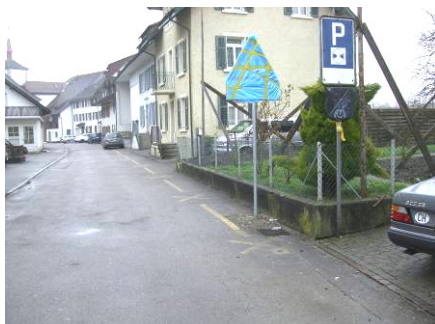
Scheunengasse vor dem Bau
