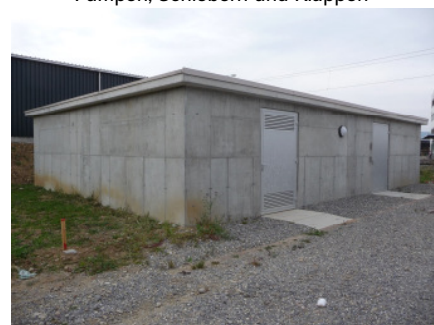
Trafostation und Stufenpumpwerk
