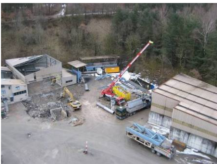
Rückbau der bestehenden Anlage
