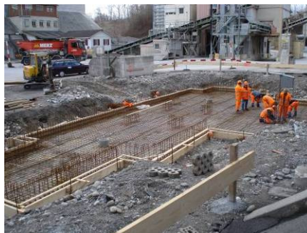
Bewehrung der Fundamentplatte
