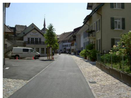
Scheunengasse nach dem Bau
