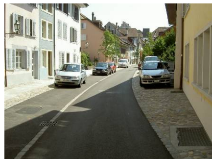
Bruggerstrasse nach dem Bau
